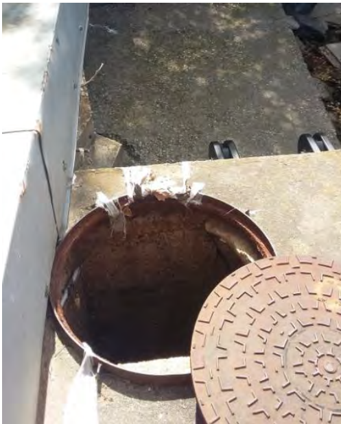
Figure 43 : Impact visuel des déversements au droit des DO91 (gauche) et DO104 (droite)
